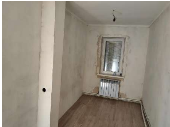
Фото 8. Внутреннее помещение жилого дома
